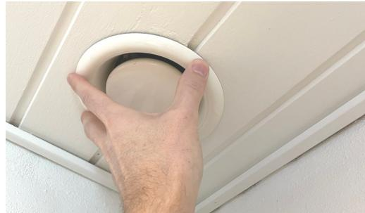
2. Placer fingrene på rammen. Rør ikke dækslet i midten. Drej mod uret.
