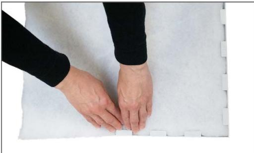
7. Filtermåtten klemmes omhyggeligt fast i filterrammen og skubbes godt ud i siderne. Filteret placeres igen i aggregatet med filtermåtten opad og gitteret nedad
